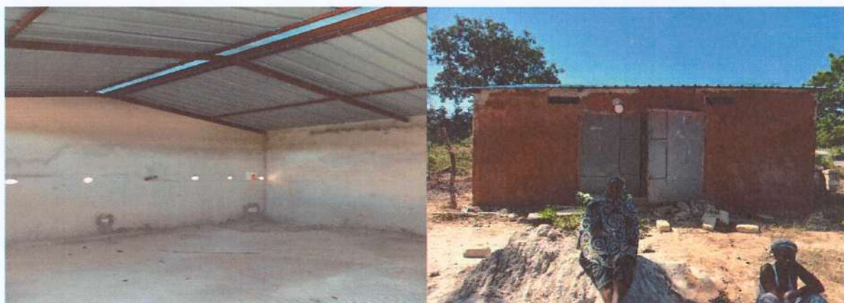
Instalación de almacenamiento para el perímetro hortícola de Niamone
